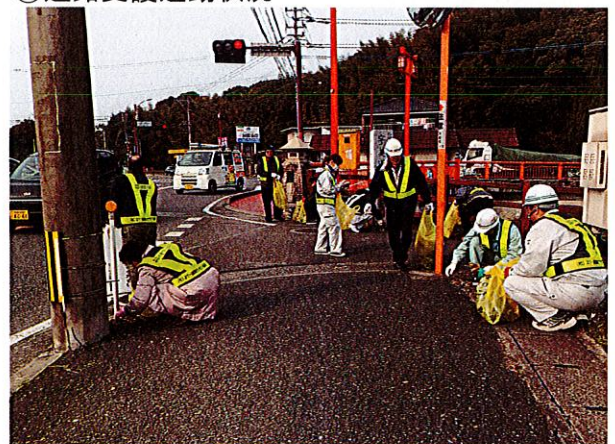
[道路清掃状況]
